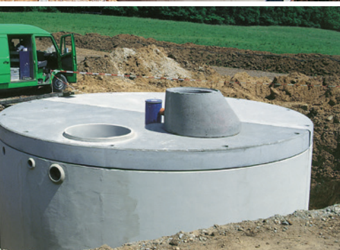
Mall-Regenspeicher aus Stahlbeton für Großanlagen
