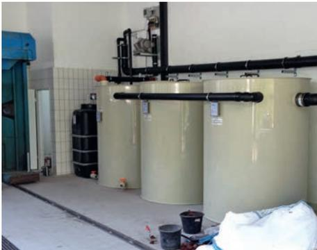
Wenn die örtlichen Gegebenheiten den unterirdischen Einbau einer Waschwasseraufbereitungsanlage nicht zulassen, können die Behälter der NeutraClear auch oberirdisch aufgestellt werden. Hierfür werden entsprechend frostgeschützte Kellerräume oder ein großer Technikraum genutzt. Die Anlage besteht aus Kunststoff und entspricht dem Anhang 49 der AbwV.
