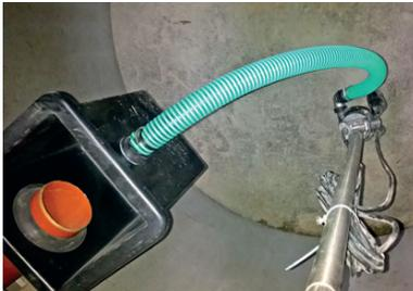
Mit dem Regencenter Tano T kann ein Mall-Regenspeicher (mit integriertem Filtersystem) nicht nur für die Nutzung (unteres Speichervolumen V1), sondern darüber hinaus nach DIN EN 12056 für die Rückhaltung von Starkregeneignissen (oberes Speichervolumen V2) dimensioniert werden.
