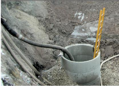
Gemäß DWA-A 138 werden Sickerschächte in einen Typ A und einen Typ B unterschieden.
