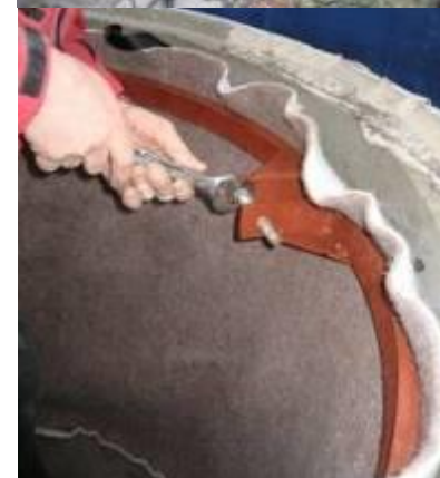
Geotextilfiltersack im Ein- bauzustand / Montagering / nach Entnahme
