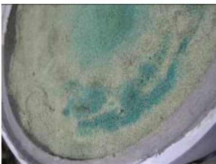
Filtergranulat im beauf- schlagten Zustand
