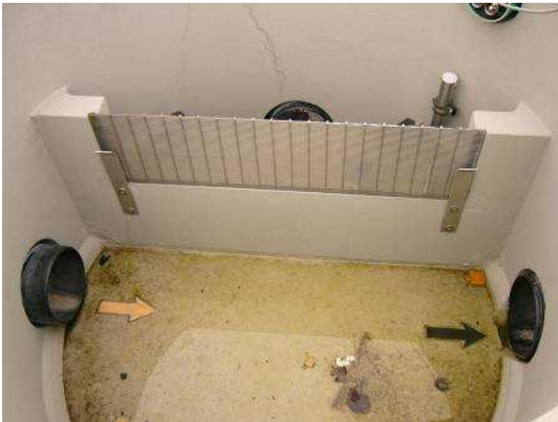
Trennbauwerk mit Messzelle und Schwimmersonde
