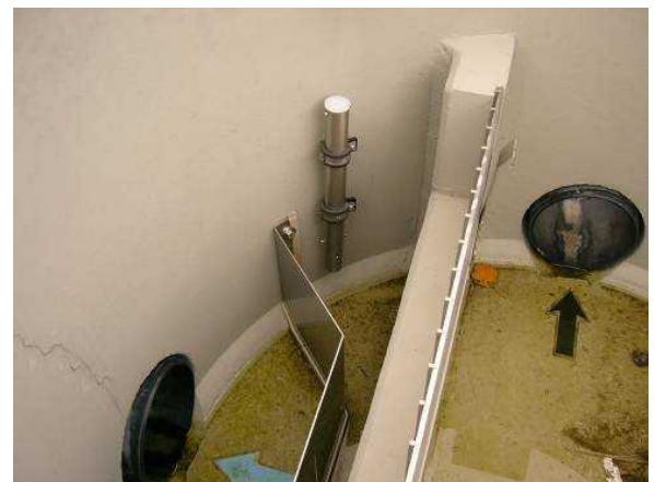
Trennbauwerk mit Messzelle und Schwimmersonde
