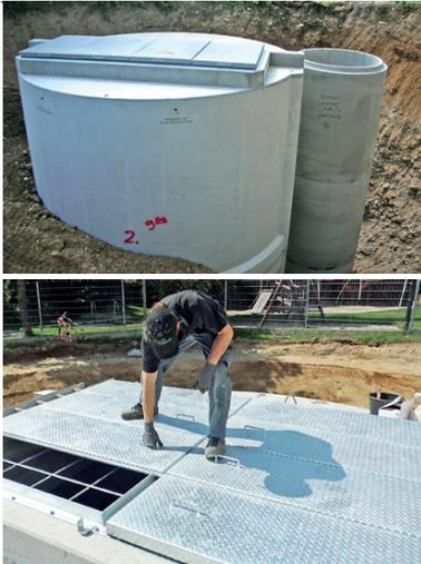
Der Einsatz von Hackschnitzelheizungen nimmt vor allem im kommunalen Bereich zu. Daher bietet Mall einen Hackschnitzelspeicher von 40 m<sup>3</sup> bis 120 m<sup>3</sup> Nutzvolumen mit LKW-Schüttöffnung für verschiedene Entnahmesysteme an. Mit dem Hackschnitzelspeicher unterstreicht Mall seine Vorreiterstellung bei der Produktion von Stahlbeton-Fertigbehältern.
