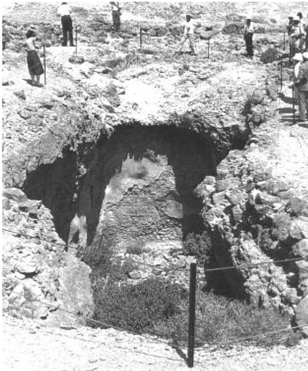
ten sowohl der Wasserentnahme als auch der Reinigung von Schlamm und Sand, die mit dem Hochwasser in die Zisternen getragen wurden. Der Wasserzulauf erfolgte in den meisten Fällen über eine kleine Einlaufkammer.
