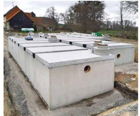
Absetzanlage nach RiStWag NS 210 mit nachgeschalteten Regenrückhaltebecken
