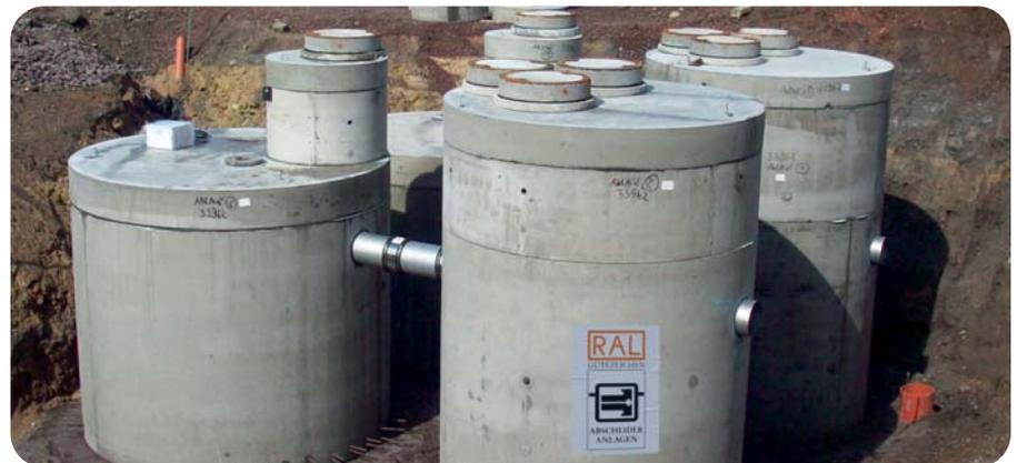
4. Vor dem Einbau der Abscheideranlage muss das Bauunternehmen die Oberfläche der Baugrubensohle überprüfen. Die Anforderungen aus dem Standsicherheitsnachweis nach DIN 19901 sind einzuhalten. Dazu gehört eine Überprüfung der Sohl- und Bodenpressung. Nur so kann eine dauerhaft dichte Ausführung im Zu- und Ablaufbereich garantiert werden.
