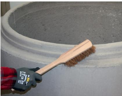
Bild 4: Reinigung der Verbindungsflächen
