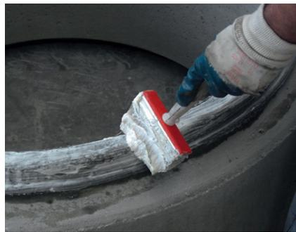
Bild 5: Auftragen des Gleitmittels
