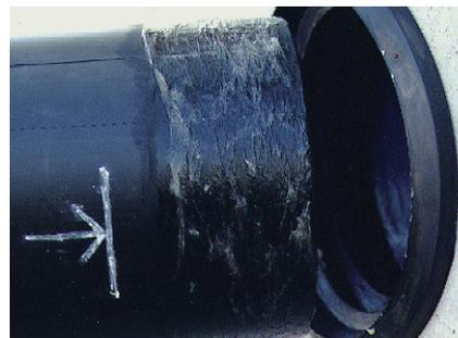
Bild 8: Herstellen der Rohranschlüsse
