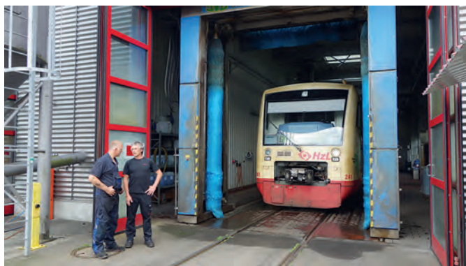
Bild 2. Betriebswerkstatt der Hohenzollerischen Landesbahn in Immendingen: Zur Instandhaltung und Pflege der Schienenfahrzeuge gehört eine Wäsche pro Woche in der Portalwaschanlage mit Kreislauf- und Regenwasser. (Fotos 1 und 2: König)
