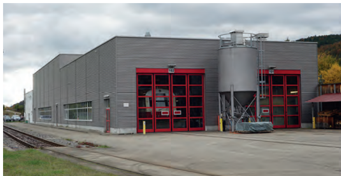
Bild 1. Betriebswerkstätte der Hohenzollerischen Landesbahn in Immendingen, 2003 neu gebaut. Das auf den Dachflächen auftreffende Regenwasser wird gesammelt. Es dient als Frischwasser beim letzten Spülgang und ersetzt den Verschleppungsverlust bei der Kreislaufführung des Waschwassers.
