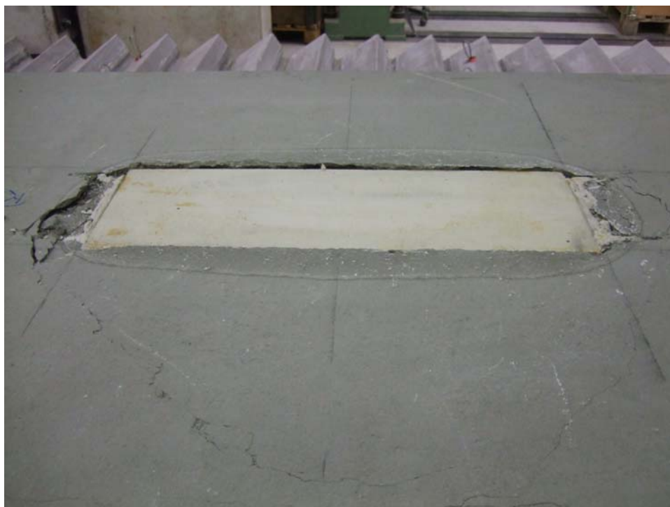
Bild 2: Prüfkörper Nr. 2, Draufsicht der zerstörten Abdeckplatte nach Durchführung der Prüfung
