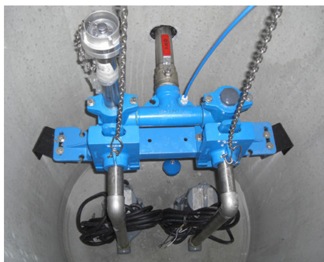
Für den individuellen Bedarf dimensionierte Hebeanlagen liefert Mall mit werkseitiger Vorausrüstung. Im Bild die Ausführungsvariante als Doppel-pumpstation, wie sie unter Umständen bei Fettabscheidern obligatorisch ist
