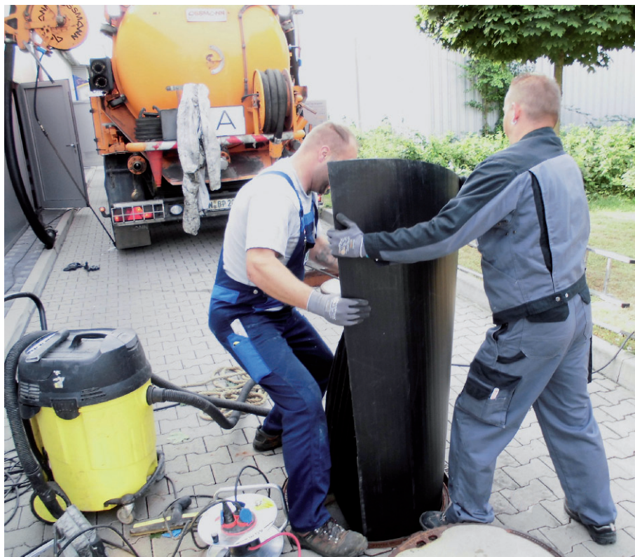
Vorgefertigte Plattenelemente aus Polyethylen hoher Dichte ermöglichen eine schnelle Montage in schadhafte Schlammfängen und Abscheidern.
