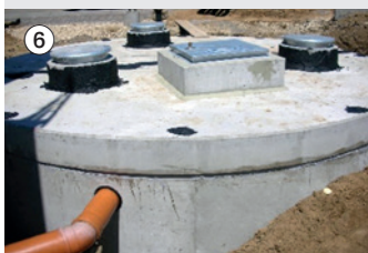
Rohr DN 200 einschieben
