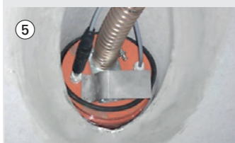
Adapterplatte – DN 2500 und DN 3000
