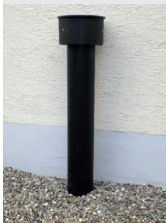
Lüftungsrohr mit schlagregensicherer Haube
