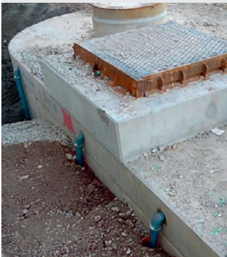
Entwässerungsanschlüsse seitlich
