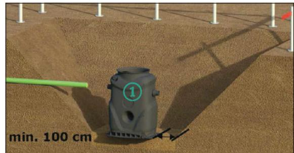
6. → Baugrube schichtweise verfüllen.
