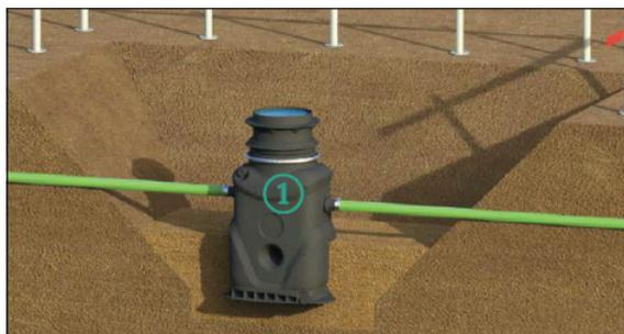
17. → Baugrube schichtweise verfüllen.
