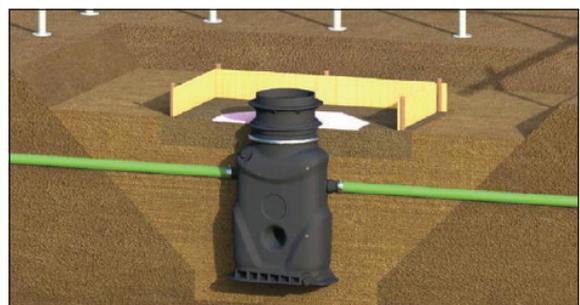
21. → Grundfläche der Lastverteilerplatte innerhalb der Schalung vollständig mit PE-Folie (mindestens 0,5 mm) auslegen.
