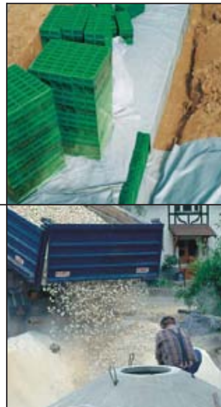
Varianten der unterirdischen Versickerung nach Passage der belebten Bodenzone Oben: Mall Sickerblock Unten: Anlegen einer Kiesrigole
