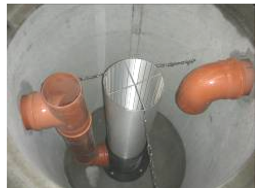
Zentrale Hebevorrichtung am Filter
