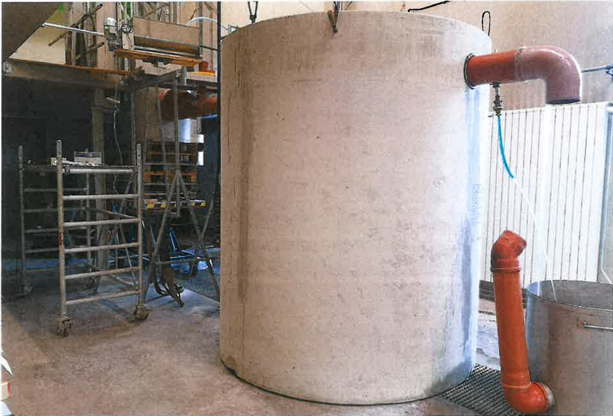
Abb. 1: Blick auf den Versuchsaufbau mit Zulauf (links oben), Lamellenklärer (Mitte) und Probenahme und Ablauf aus der Behandlungsanlage (KG-Rohr, rechts im Bild).
