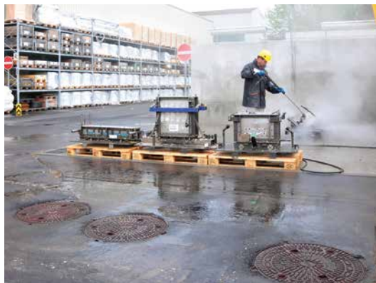
Waschplatz mit erdverbauten Abscheideranlagen
